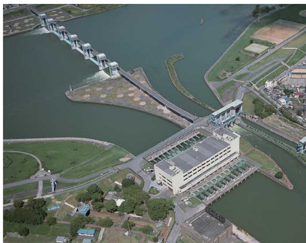
写真：淀川大堰、毛馬水門閘門
