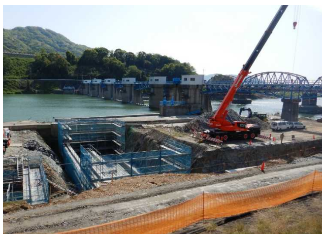
写真：岩出狭窄部対策 ※現場は施工後となります。
