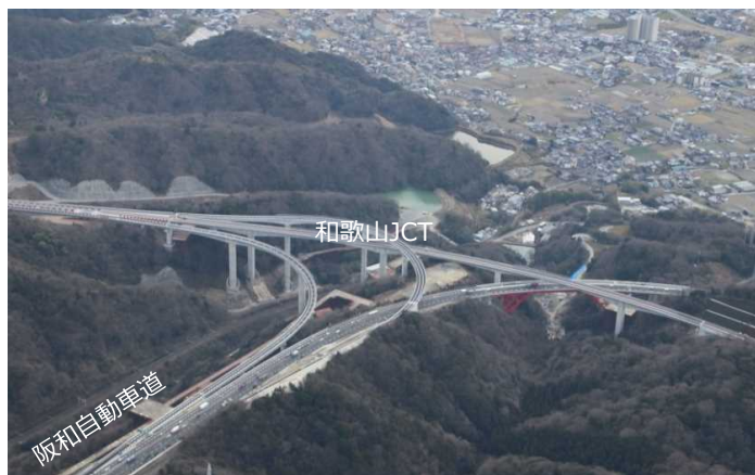
写真：京奈和自動車道（紀北西道路）
