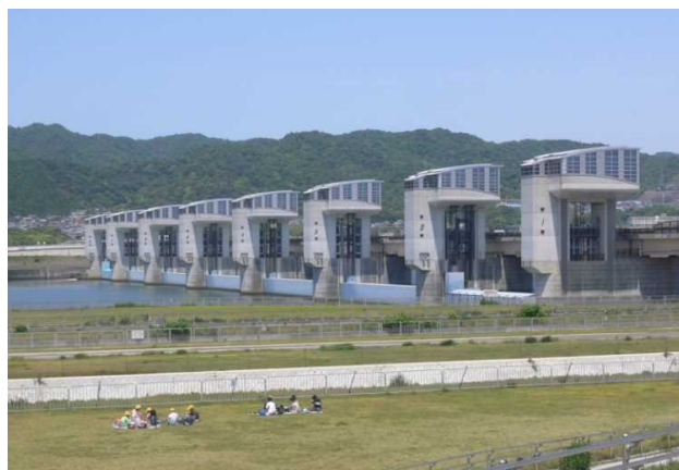
写真：紀の川大堰
