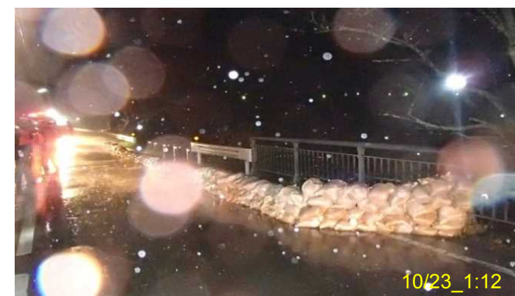
<積み土のう工完了>
