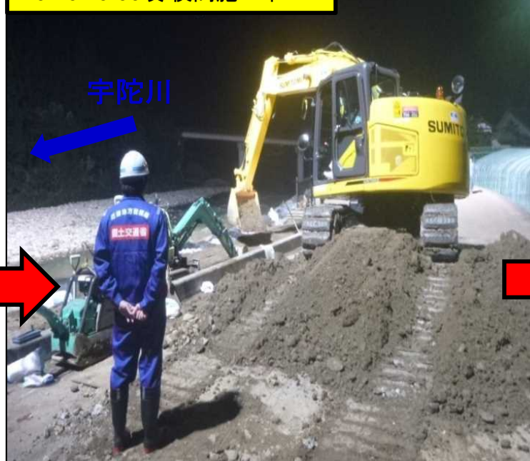
10/26 19:00頃 夜間施工中
