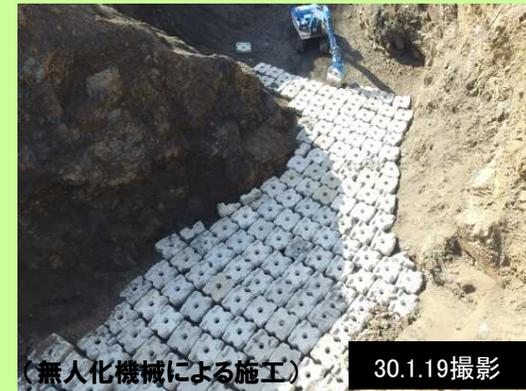
工事用道路等の応急復旧と並行して、砂防堰堤堆積土砂の撤去を実施し、落差部侵食防止は平成30年1月下旬頃に完了の見込み。
