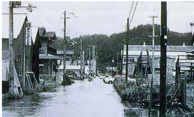
昭和49年7月 台風8号による水害の状況
