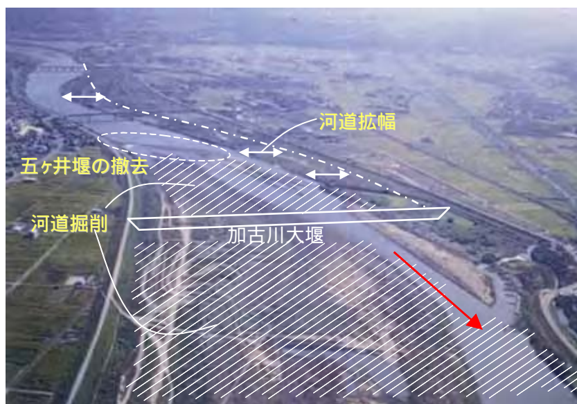
図1.2-2 河川改修の状況
