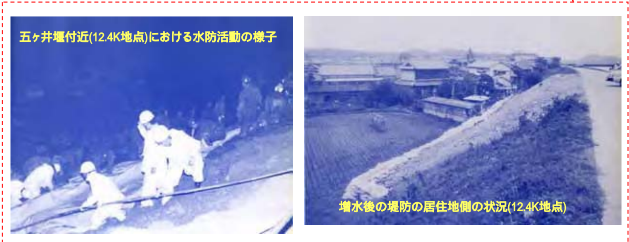
図1.1-13 昭和58年9月(台風10号)の加古川下流域の浸水状況
