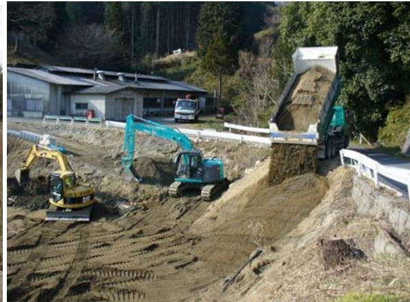
写真 4.5.3-2 道路拡幅工事への活用の状況
