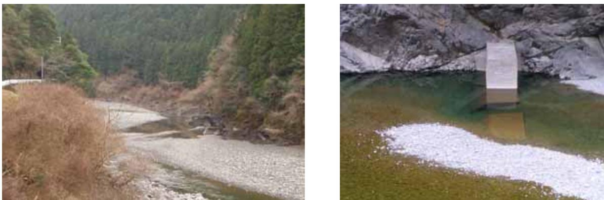
図 4.4 - 2 貯砂ダムにおける堆砂の状況（左：全景、 右：貯砂ダム状況）
