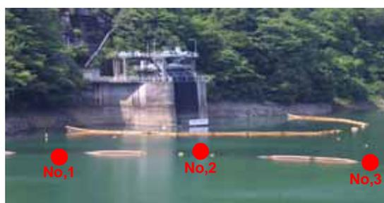
猿谷ダム付近の高濁度水が取水口付近に流れ込まないように濁水対策フェンスを二重に設置した。
