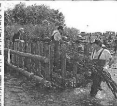
間伐材で消波堤を築く参加者ら (能登川町東新田)
