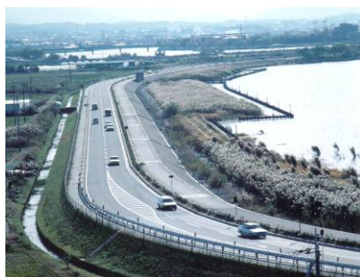
湖岸堤と前浜（植栽されたヨシ帯）
