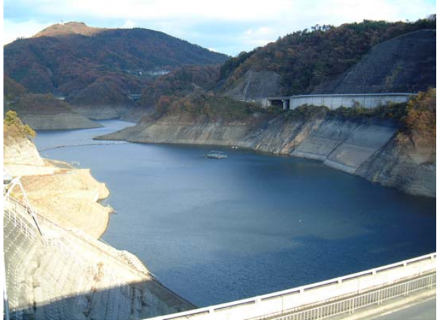
写真 ダム貯水池
