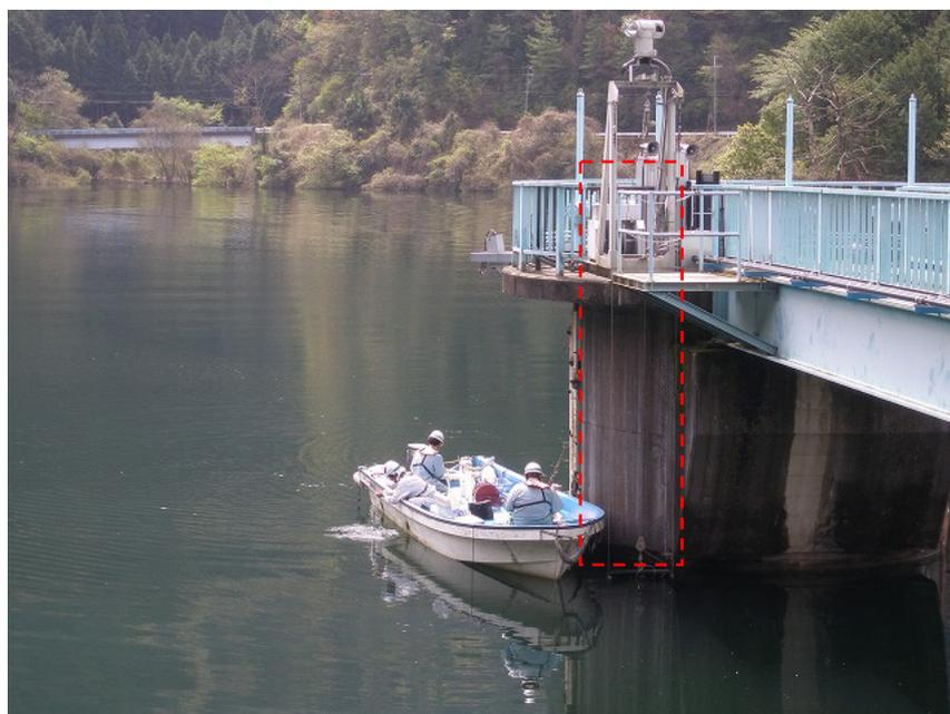
図 2-8 水質自動監視装置の設置状況 (初瀬)
