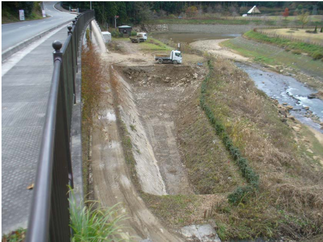
図 上流ストックヤード写真（ストック量：約 1,300m 3 ）
