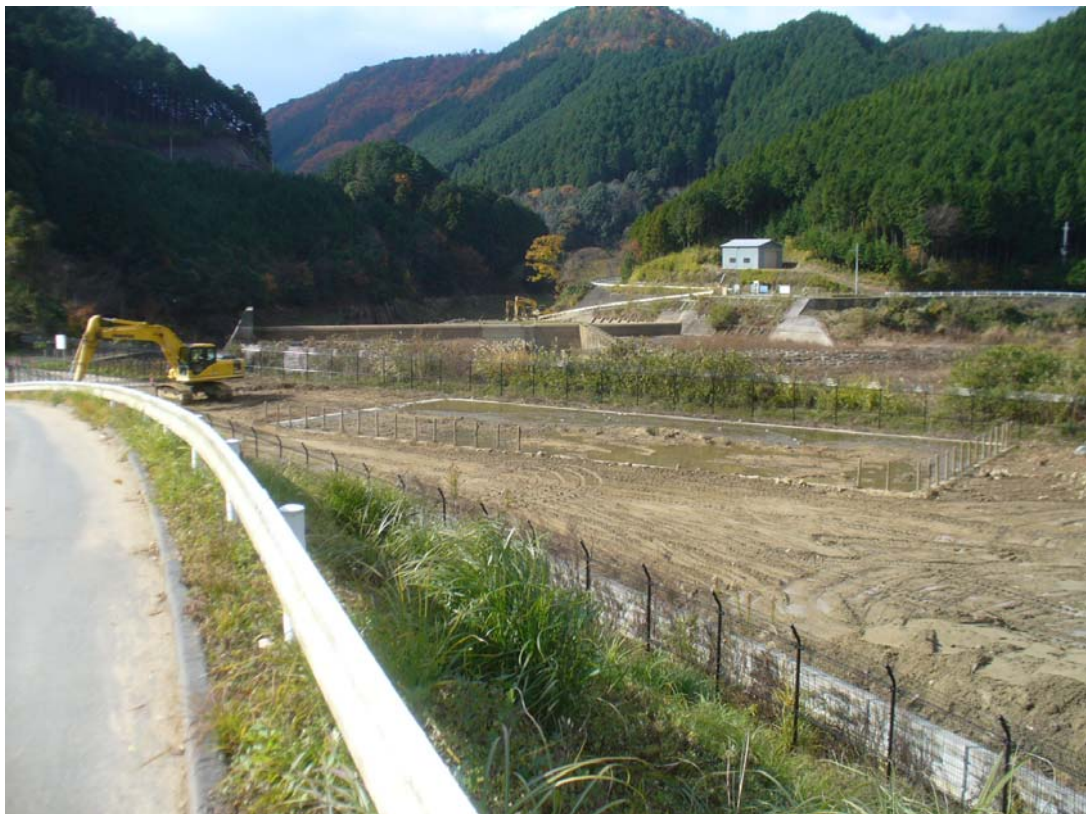
図 下流ストックヤード写真（ストック量：約 300m 3 ）
