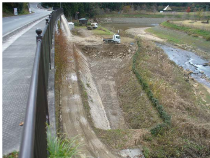
上流ストックヤード (ストック量 : 約 1,300m 3 )
