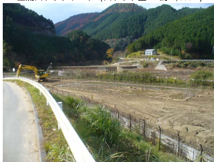
下流ストックヤード (ストック量 : 約 300m 3 )
