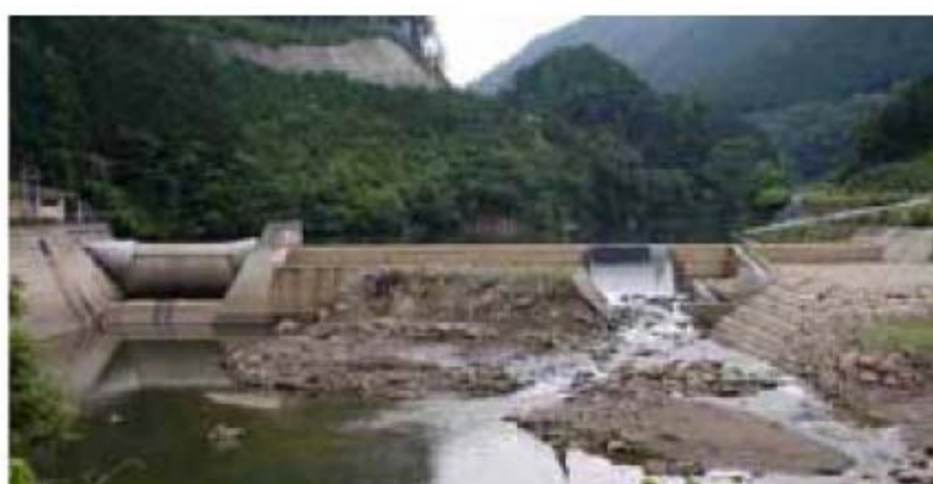
図 4.4.1-1 水質保全ダムの設置状況
