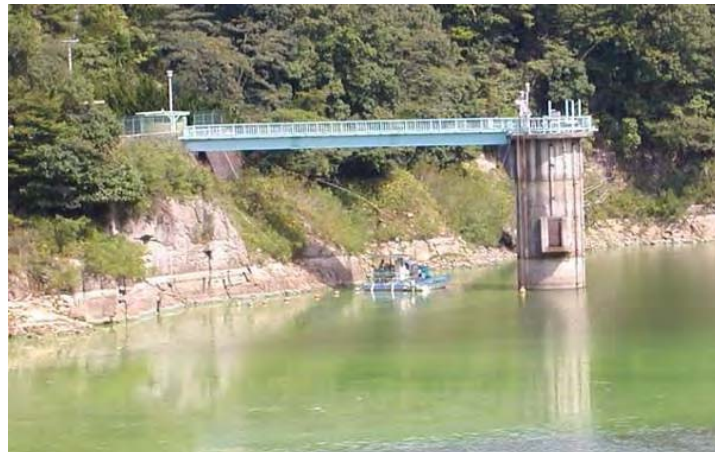
藻類処理装置設置状況(初瀬取水塔)
