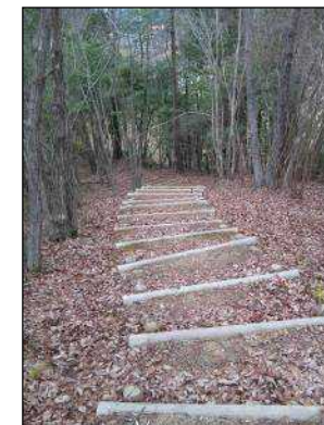
遊歩道の整備
