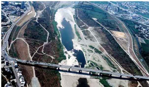
船戸地点の瀬切れ状況(H6)
