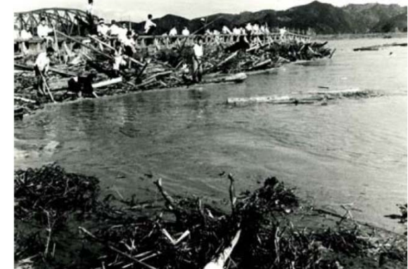
和歌山市南海橋の被害状況 (昭和34年伊勢湾台風)
