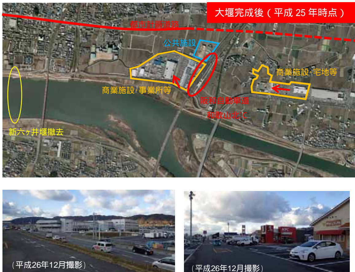
図 7.2-2 直川地区の土地利用状況
