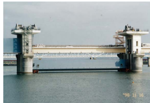
主ゲートの据付
