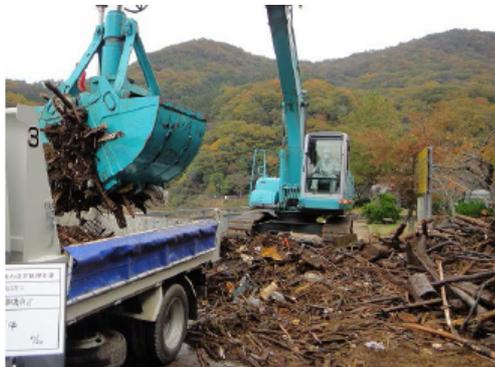
図 2.4-12 流芥の陸上げ作業（下流網場付近）
