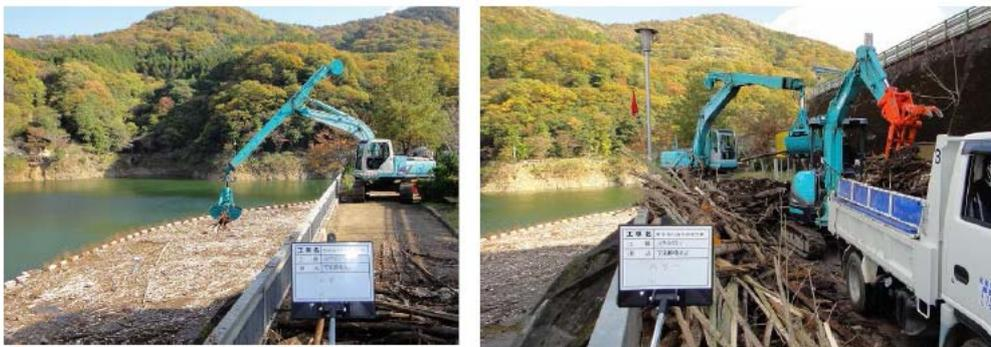
図 2.4-11 流芥の改修状況（下流網場付近）
