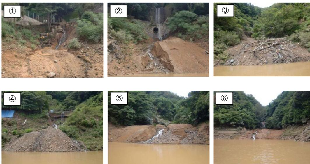
図 4.3-3 土砂流失、湖岸法面の侵食・崩落の状況 (平成 24 年度)
