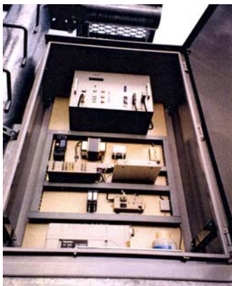
図 5.2-5(3) 鹿跳橋地点水質自動観測装置(操作盤・センサー部・立面図)
