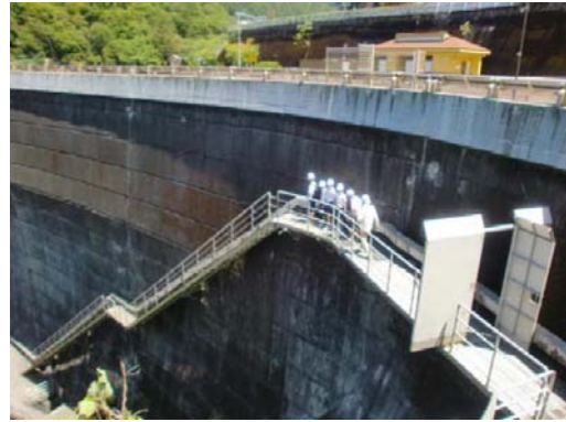
ダム本体の点検
