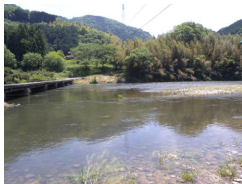
12時10分頃(有市潜没橋右岸から左岸を望む) 最大増水時
