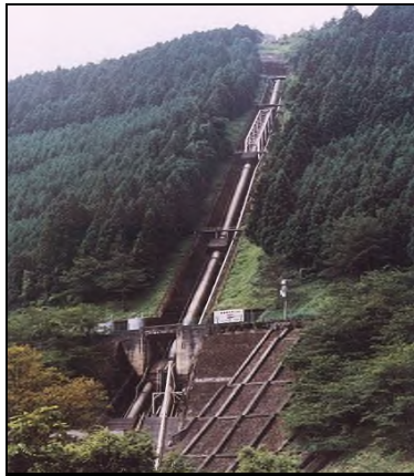
西吉野第一発電所
