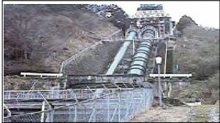
西吉野第二発電所
