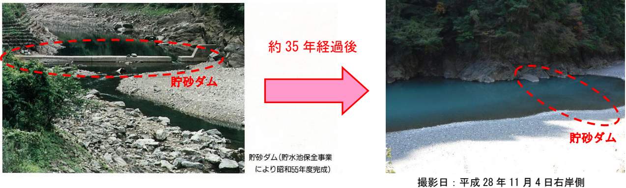
図 4.5.2-2 貯砂ダムにおける堆砂の現状
