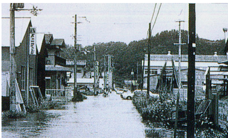
昭和 49 年 7 月 台風 8 号による水害の状況
