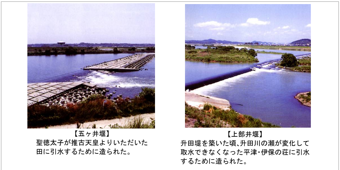
写真 1.1-2 五ヶ井堰と上部井堰の状況
