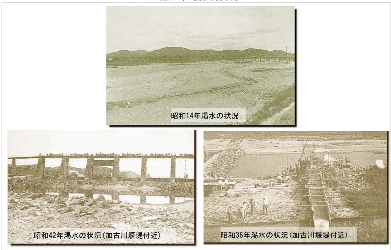
写真 1.1-3 過去の渇水被害の状況
