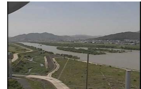
下流河川監視
