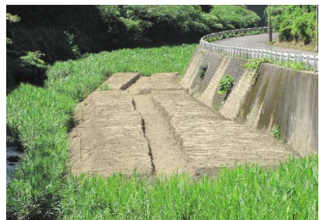
写真 下流河川への土砂還元
