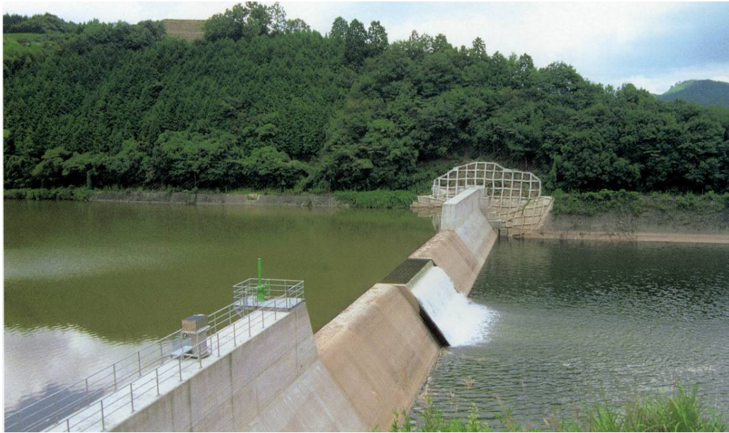
図 4.5.2-2 副ダムの設置状況
