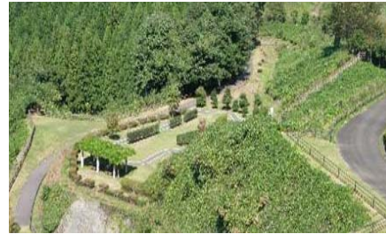
ダム右岸下流広場
