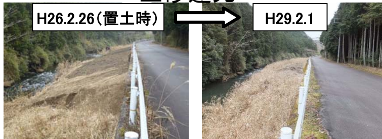
土砂置土状況
