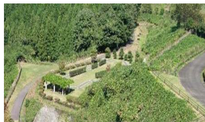
ダム右岸下流広場
