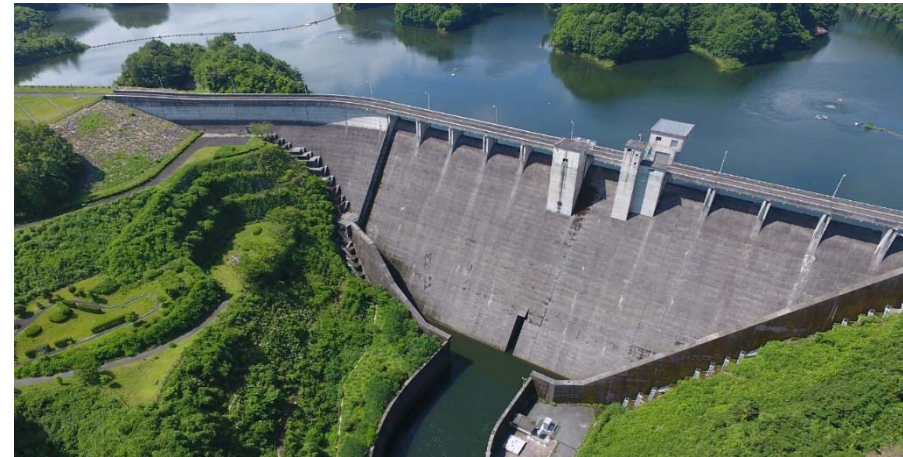
布目ダム全景
