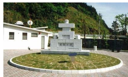
ダム左岸広場
