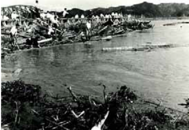
図 1.1.3-3 和歌山市南海橋の被害 状況 (昭和 34 年伊勢湾台風)
