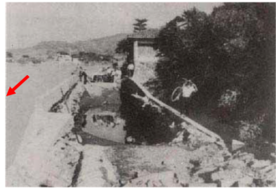
図 1.1.3-2 県道海南九度山線：麻生津～ 竜門間の被害状況 (昭和 28 年台風 13 号)
