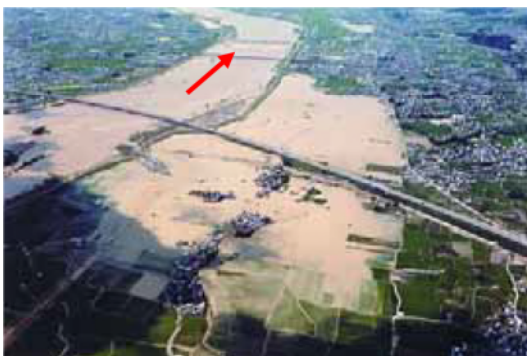
図 1.1.3-6 和歌山市直川地区の浸 水状況 (昭和 57 年台風 10 号及び台風 9 号からかわった低気圧)
