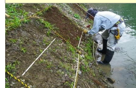
土留めの設置
