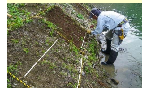
土留めの設置
