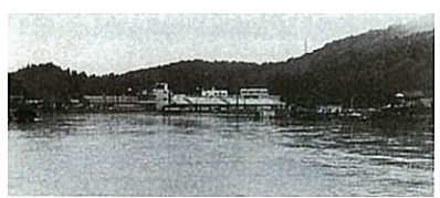
坂井郡金津町管野水口付近
