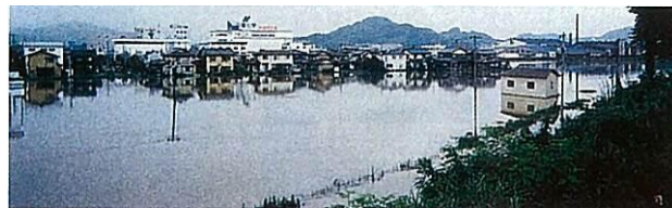
浸水状況（浅水川左岸御幸町内）
