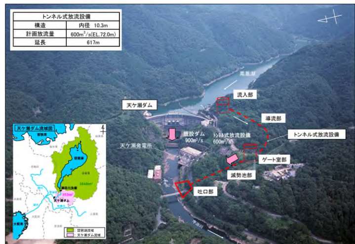
図 1.2.1-8 トンネル式放流設備概要図(イメージ図)
