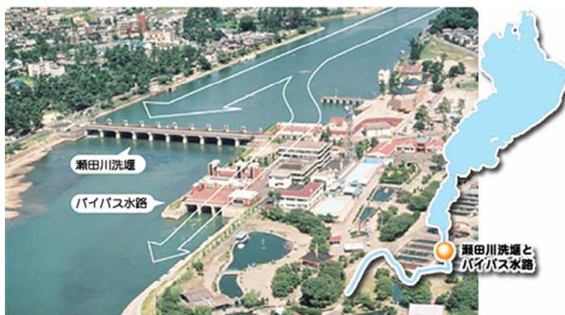
図 1.3.4-1 瀬田川洗堰バイパス水路
