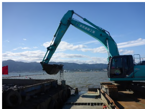
志那漁港浚渫
