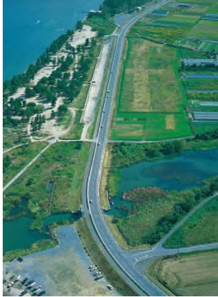
1) 湖岸堤・管理用道路の建設
