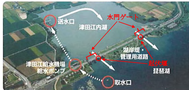
写真 1.3.4-2 津田江内湖の水位保持施設
