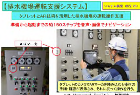
排水機場運転支援システム
