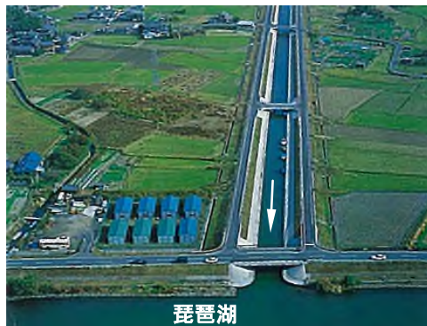
湖岸堤関連の河川河道改修
