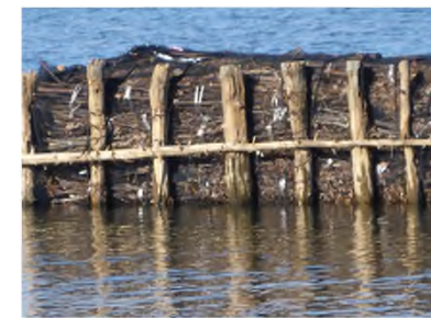
補修後の粗朶消波工の状況写真 (2017年12月6日)
