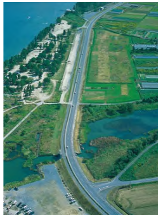
湖岸堤の建設(50.4km)
