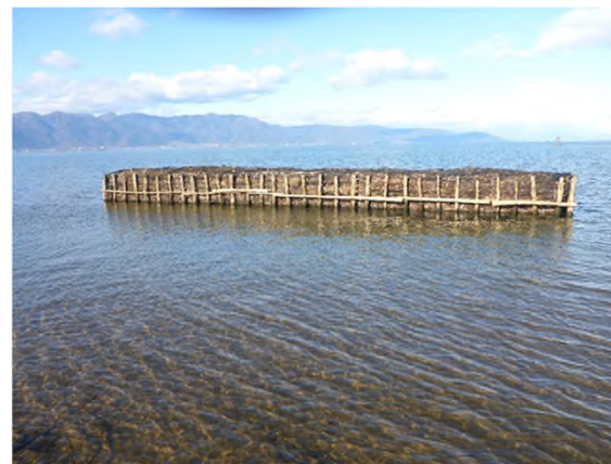
補修後の粗朶消波工の状況写真 (2017年12月6日)
