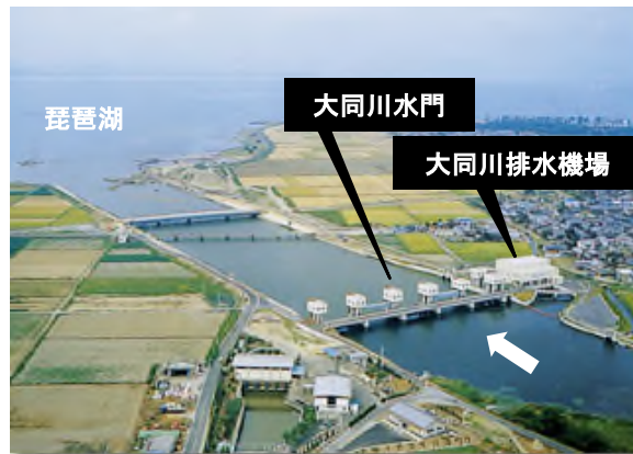
内水排除施設(14箇所)
