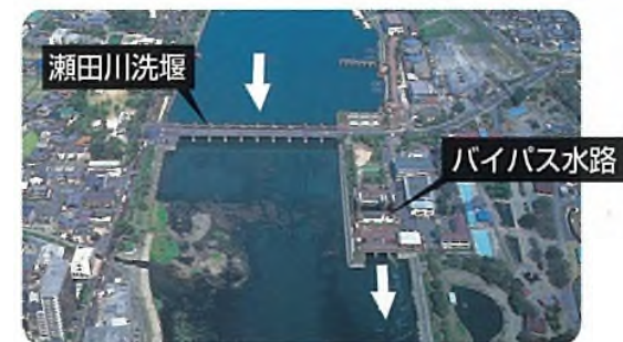
瀬田川の浚渫及び瀬田川洗堰バイパス水路
