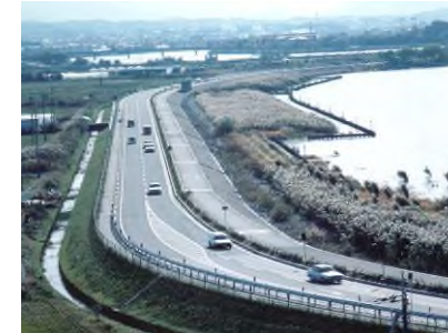
湖岸堤と前浜(ヨシ植栽を実施)
