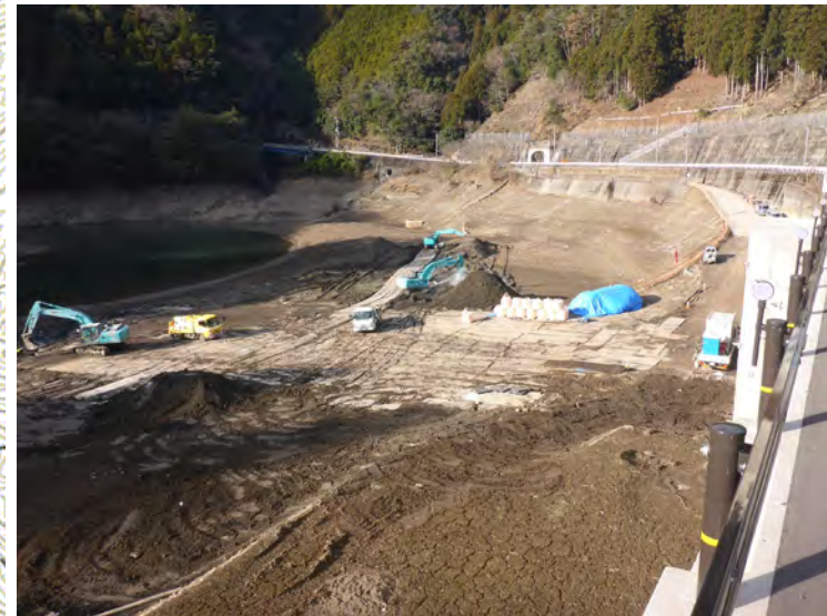
掘削状況 (令和6年度)
