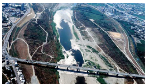
船戸地点の瀬切れ状況（H6）
