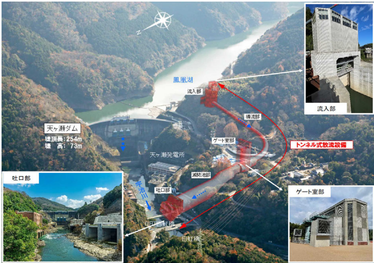
図 1.2-5 トンネル式放流設備全景写真図
