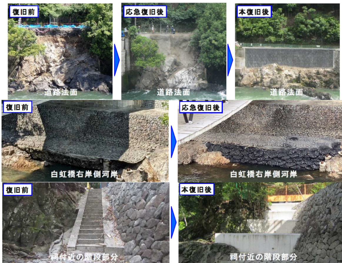
図 1.6-7 工事箇所の復旧状況
