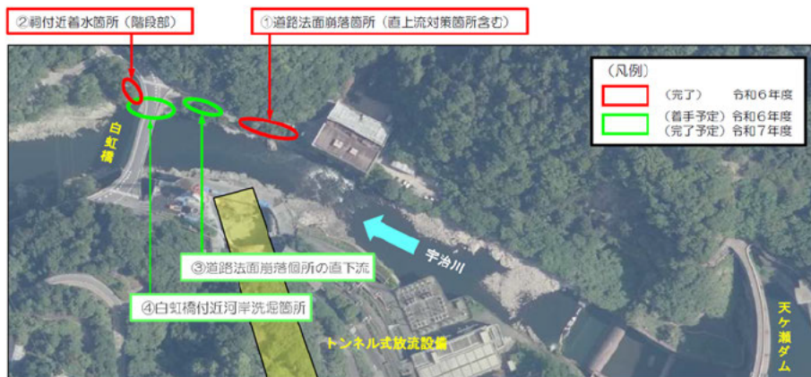
図 1.6-6 令和6年度時点の工事の進捗状況及び工事箇所
