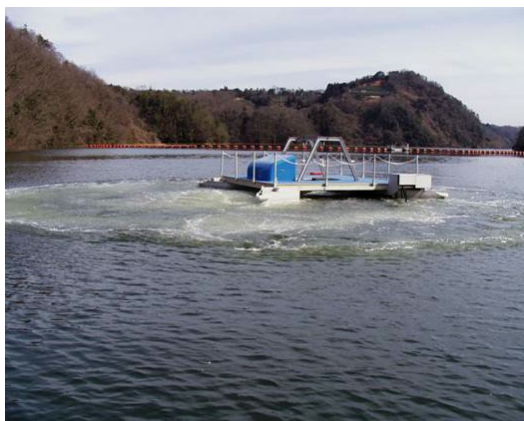
曝気循環設備
