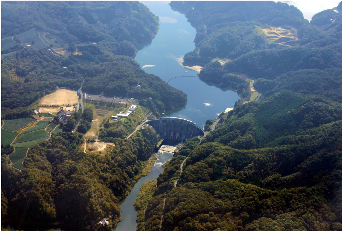
図 1.2.3-1 高山ダム全景
