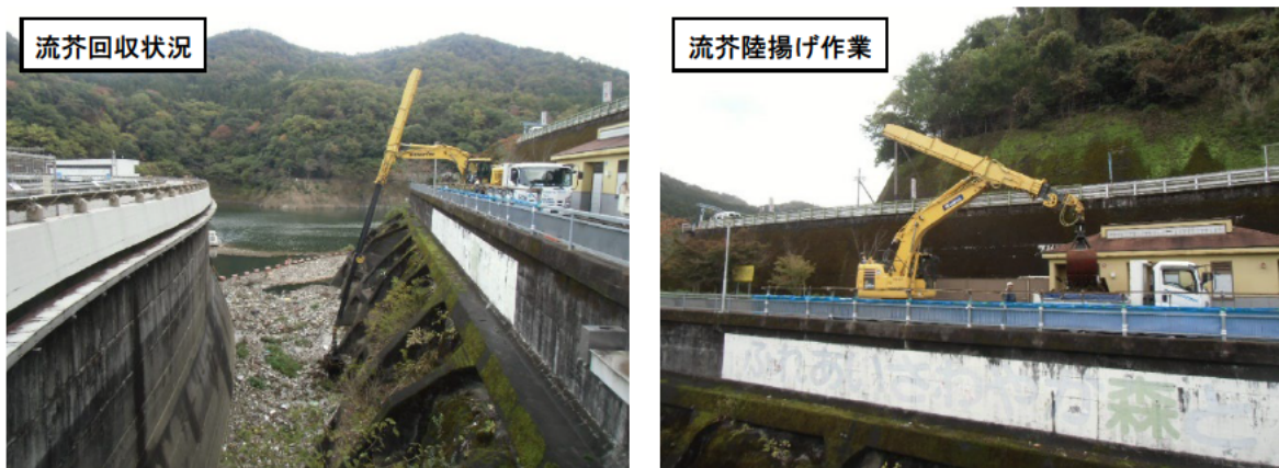
図 2.4-2 流芥回収工事の様子
