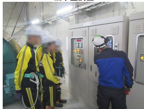
機械設備点検(2号副ゲート)
