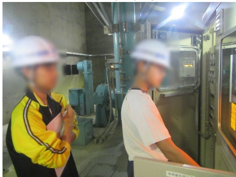
機械設備点検(トンネル主ゲート)
