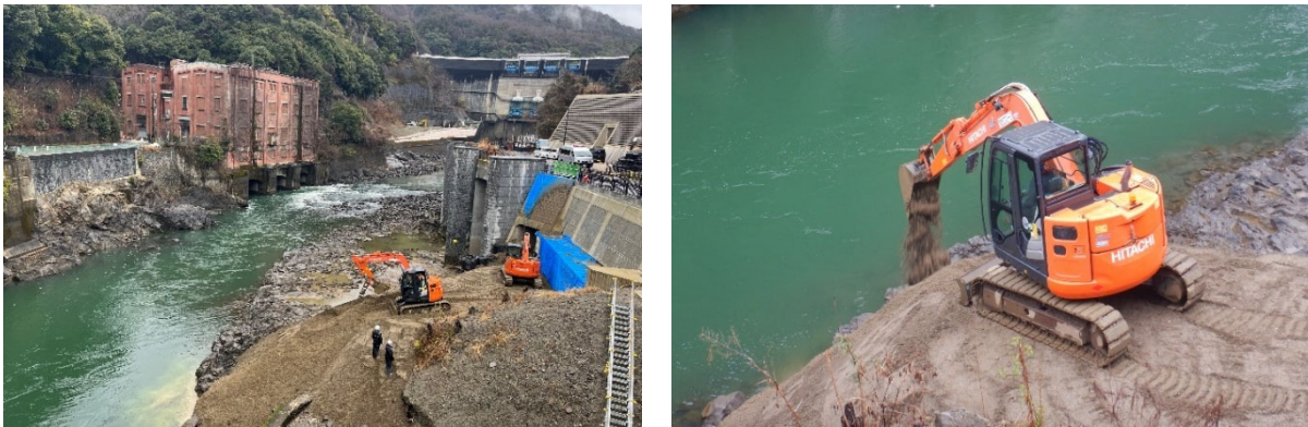
図 4.6-8 土砂還元工事の状況
