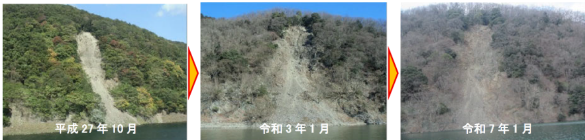
図 4.3-3 傾斜計設置箇所(①)の崩壊状況
