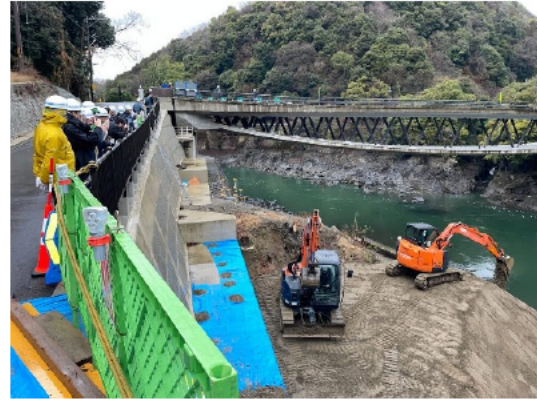
R7.3.4 現地視察会（土砂還元工事）
