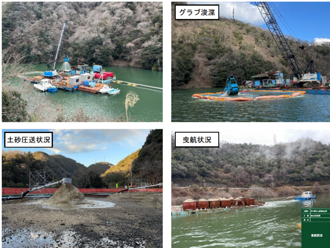
図 4.6-7 浚渫工事実施状況
