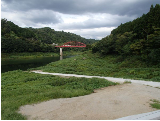
R5 堆砂除去工事 月ヶ瀬橋下流(着工前)
