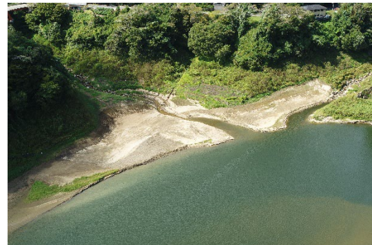
R6 堆砂除去工事 八幡橋下流(完成)
