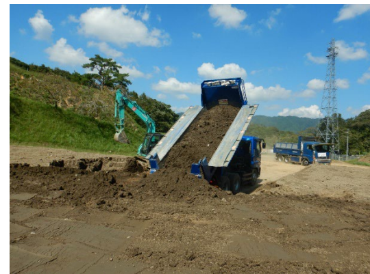
R6 堆砂除去工事 施工状況②
