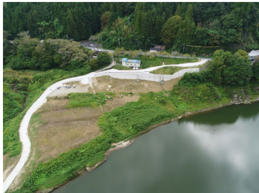
R5 堆砂除去進入路工事(完成)
