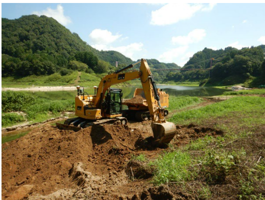
R6 堆砂除去工事 施工状況①
