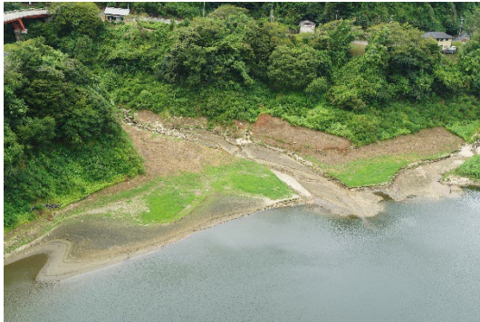
R6 堆砂除去工事 八幡橋下流(着工前)
