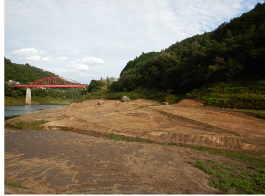
R5 堆砂除去工事 月ヶ瀬橋下流(完成)
