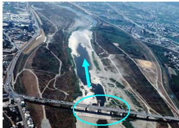
図 3.4.2-1 瀬切れ状況（平成6年8月 出橋付近）
