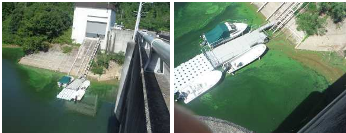
図 5.3.6-2 アオコの発生状況(ダムサイト付近、平成30年8月27日)
