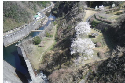
ダム右岸下流広場
