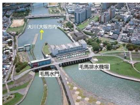
毛馬水門と排水機場(淀川左岸10k付近)
